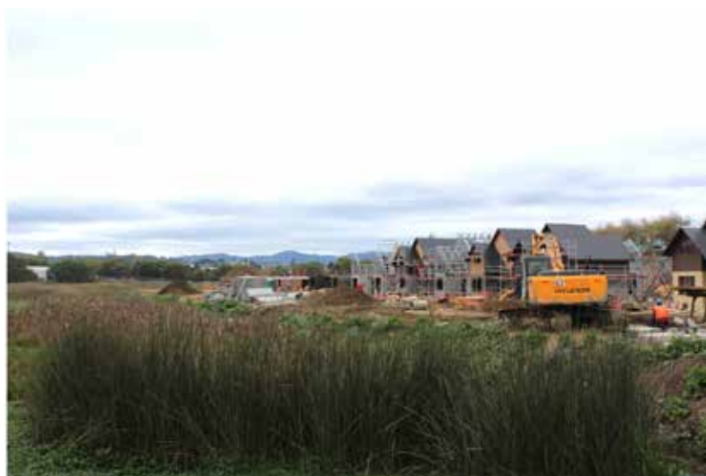
FOTO N°2. CONSTRUCCIÓN DE VIVIENDAS SOBRE EL HUMEDAL PAICAVÍ (CONCEPCIÓN). CAROLINA ROJAS, MAYO DE 2017.
